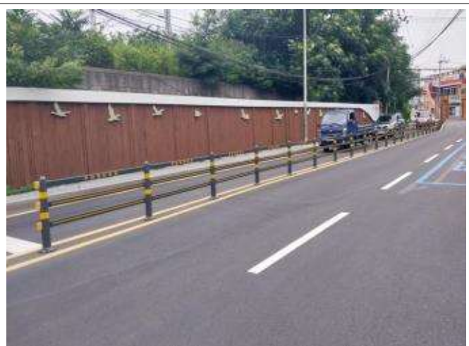
개선 후(무단횡단방지 차선분리대 설치)
