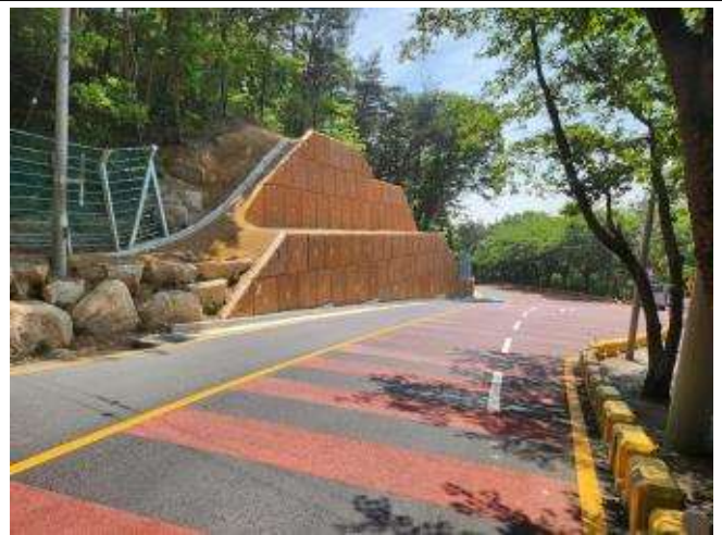
개선 후(보도폭 확장 및 옹벽설치)
