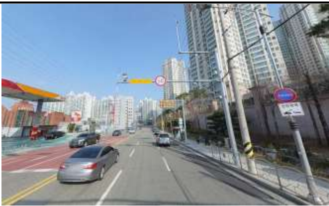
도로 사진(3차로 구간)
