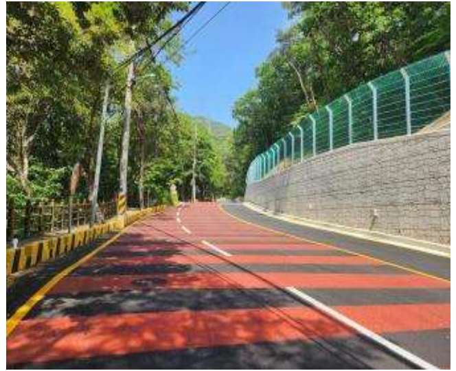
개선 후(보도폭 확장 및 옹벽설치)
