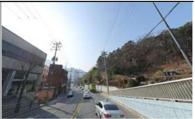
도로 사진(2차로 구간)
