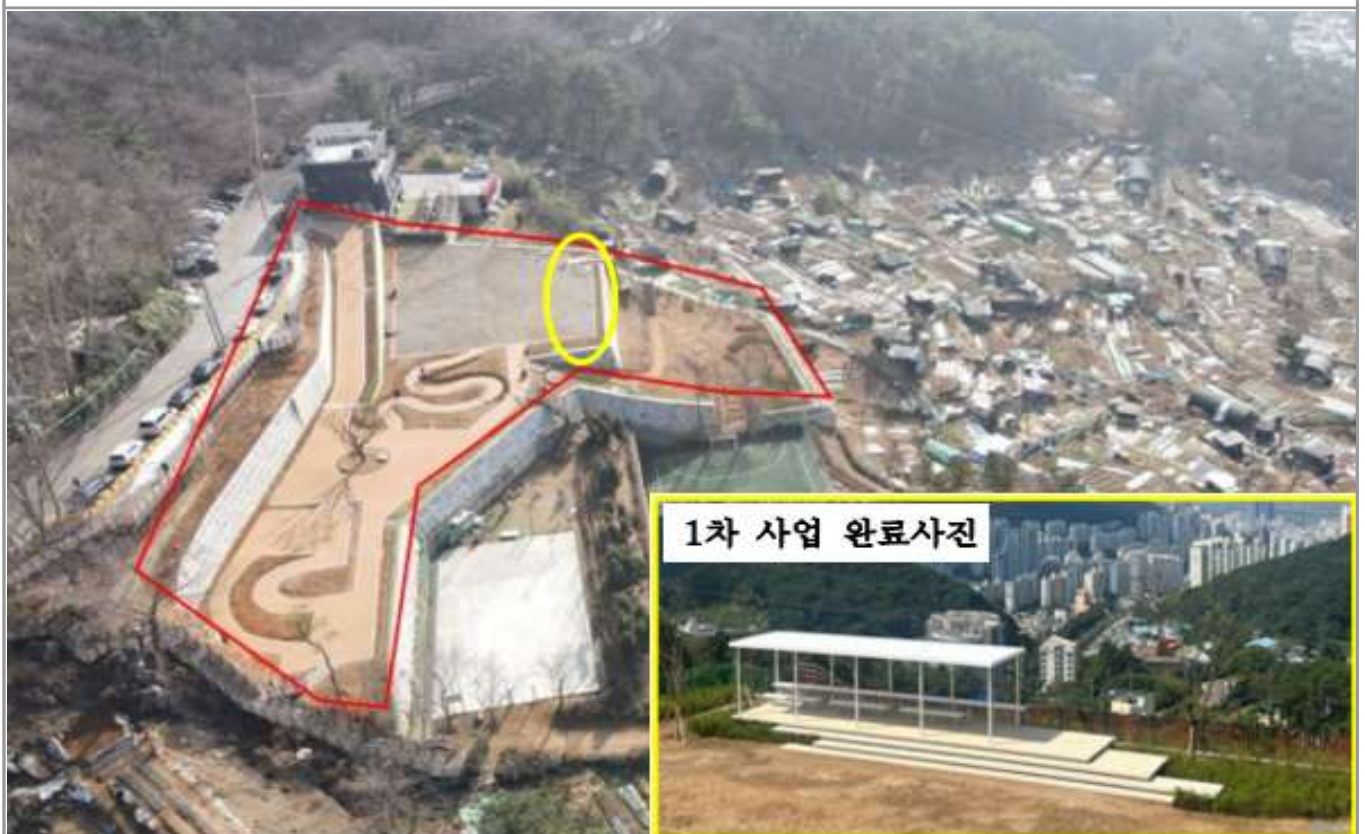
현장사진(1차 사업 ▶ 전망휴게공간 설치 및 수목식재)
